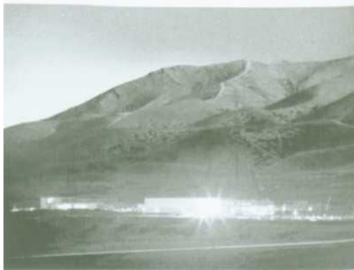
Obrázek 513: Datové centrum v Utahu za mnoho miliard dolarů má sloužit k filtrování a ukládání celosvětové komunikace.
